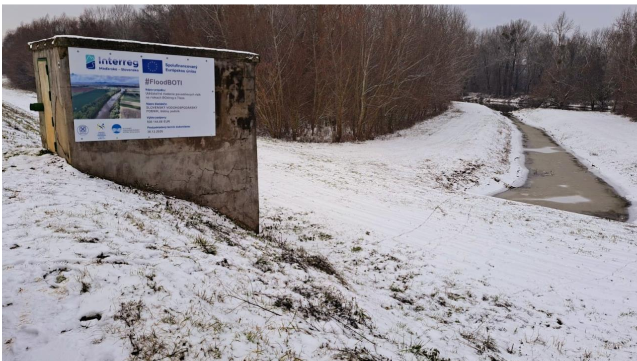
Obrázok 2 Objekt hrádzového stavidla s osadeným projektovým bilbordom
