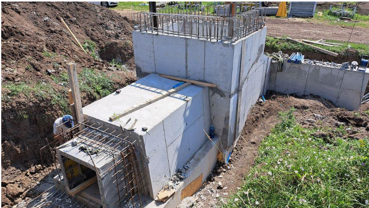
Obr. 12 - Budovanie prírodného napojenie nového nápuštného objektu
