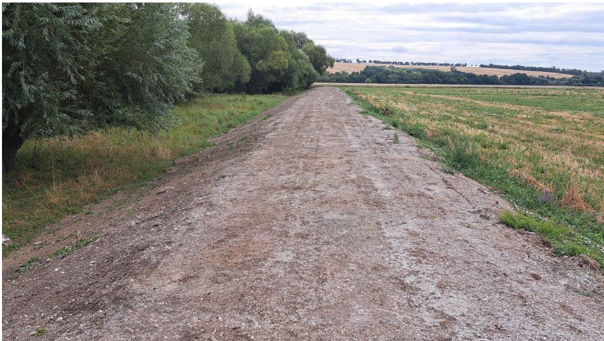
Obr. 27 - Opravená priečna koruna hrádze PR Žitavský luh navýšená na kótu ochranej hrádze zregulovanej rieky Žitava
