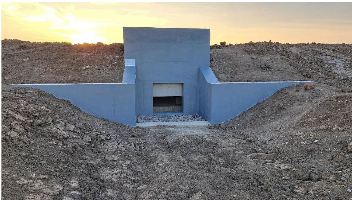
Obr. 14 - Nový odberný objekt v ľavostrannej hrádzi zregulovaného toku rieky Žitava, pohľad na náveternú stranu LOH Žitavy
