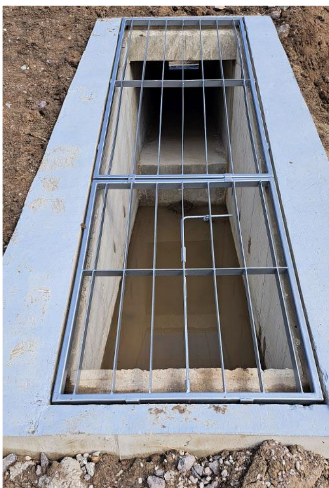
Obr. 15 - Nový odberný objekt v ľavostrannej hrádzi zregulovaného toku rieky Žitava, pohľad na návodnú stranu LOH Žitavy
