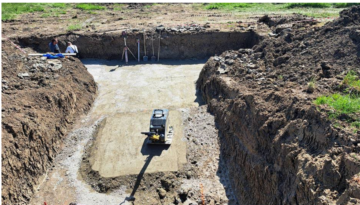
Obr. 10 - Práce na základovej doske odberného objektu
