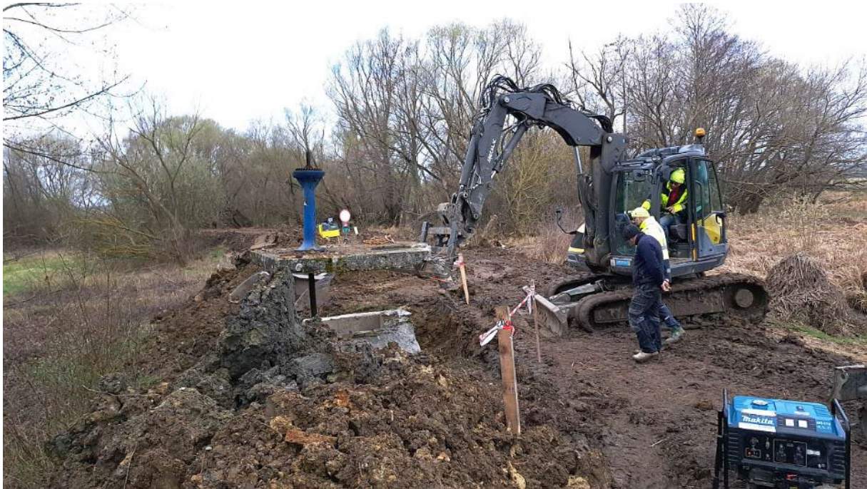
Obr. 18 - Demontáž starého poškodeného výpustného objektu
