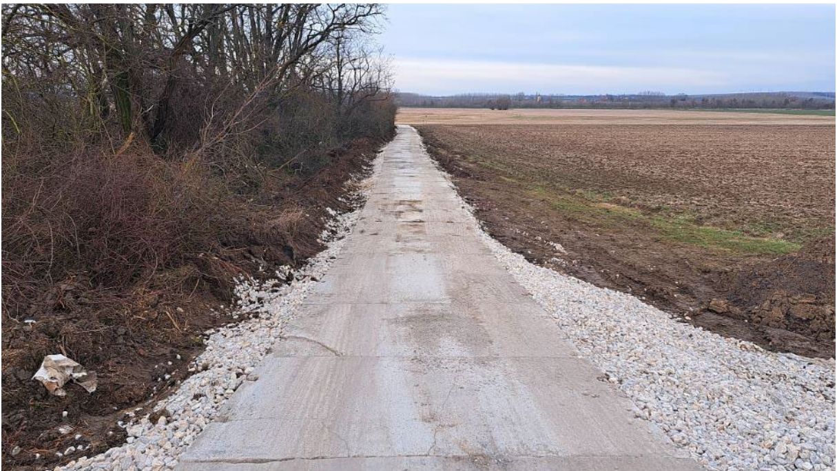
Obr. 2 – vybudovanie prístupovej cesty k zriadenému stavenisku
