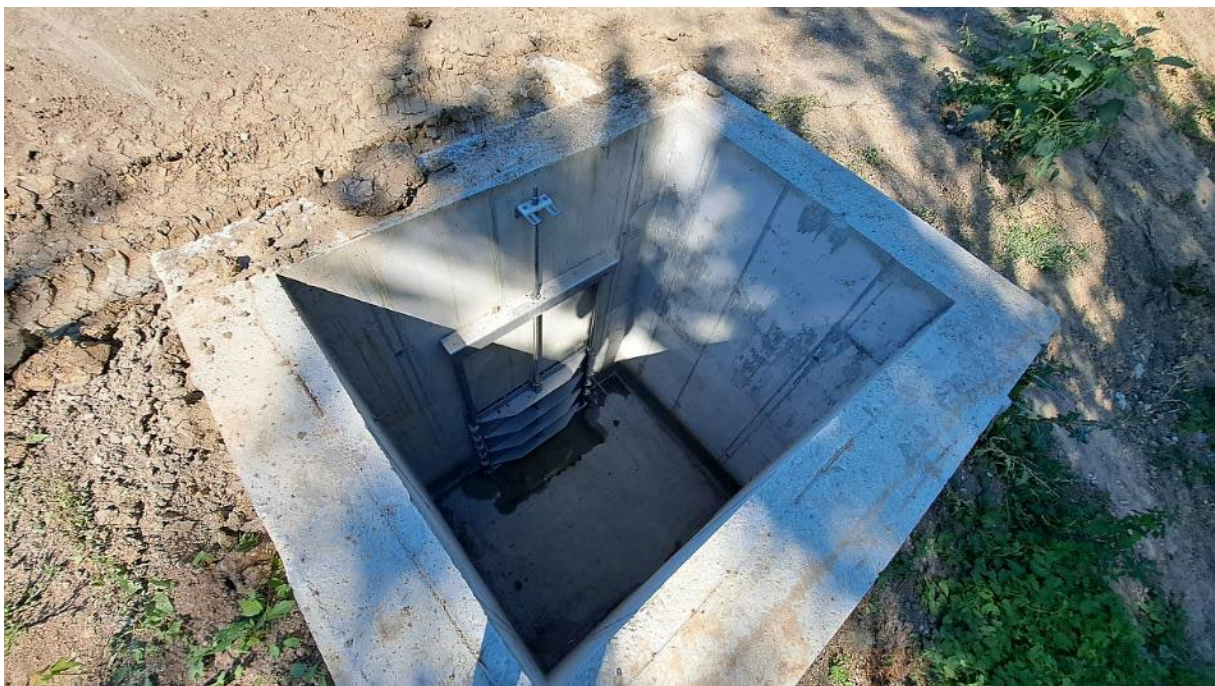
Obr. 21 - Namontované stavidlo výpustného objektu
