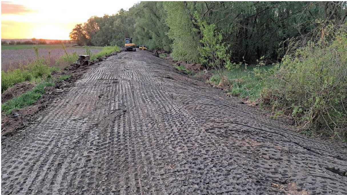
Obr. 25 - Úprava a hutnenie hrádze
