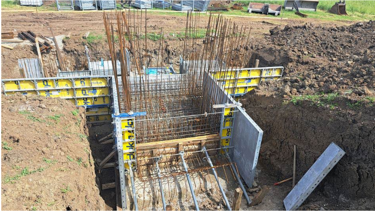
Obr. 11 - Debnenie a armovanie šachty nového nápuštného objektu
