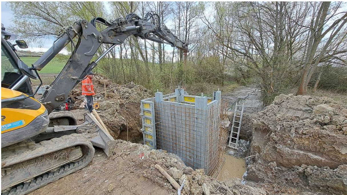
Obr. 19 - Práce na debnení pre zaliatím železnej konštrukcie šachty stavidla
