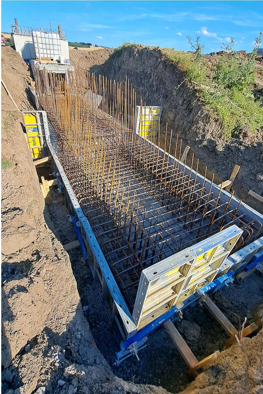
Obr. 13 - Armovanie a debnenie pred betónovaním prívodnej časti nového nápuštného objektu
