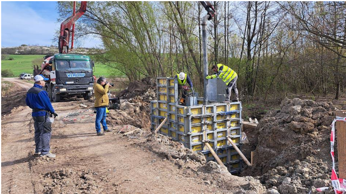
Obr. 20 - Betónovanie šachty výpustného stavidla
