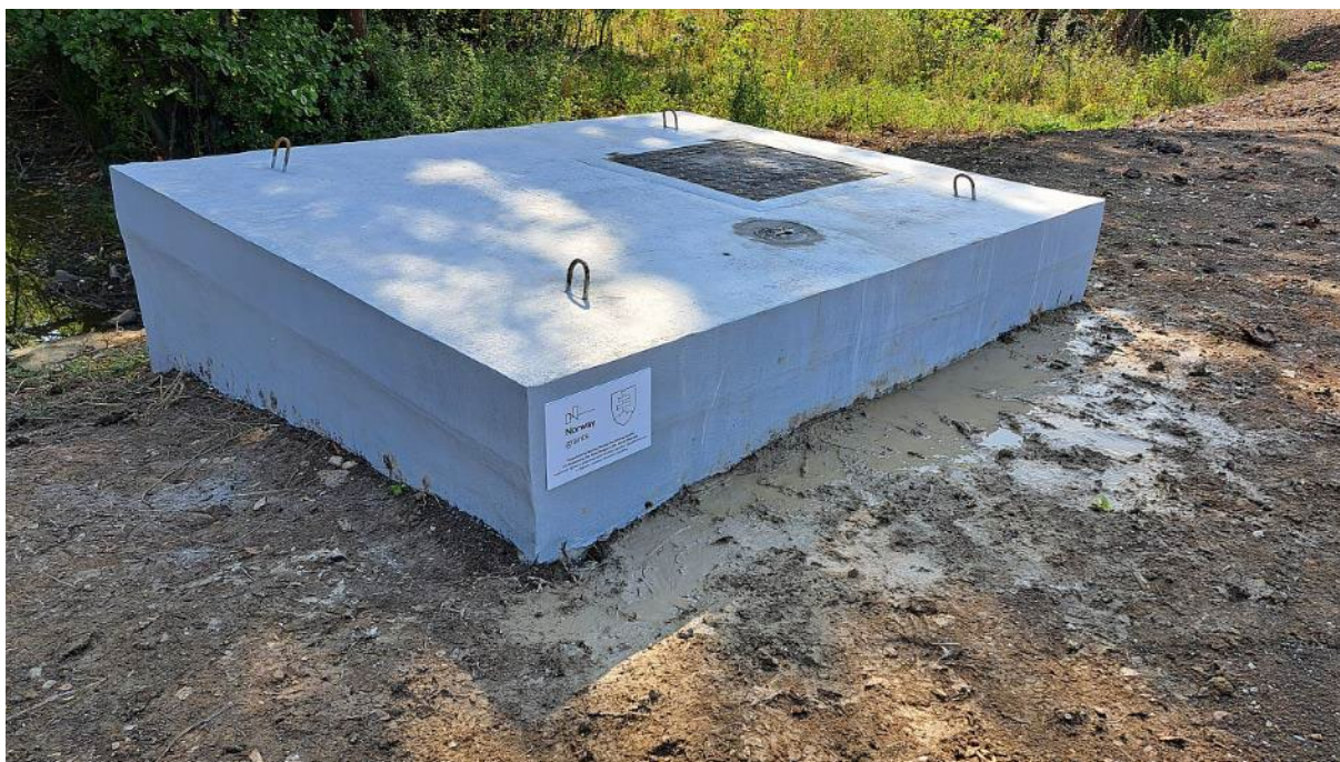
Obr. 22 - Nový výpustný objekt PR Žitavský luh
