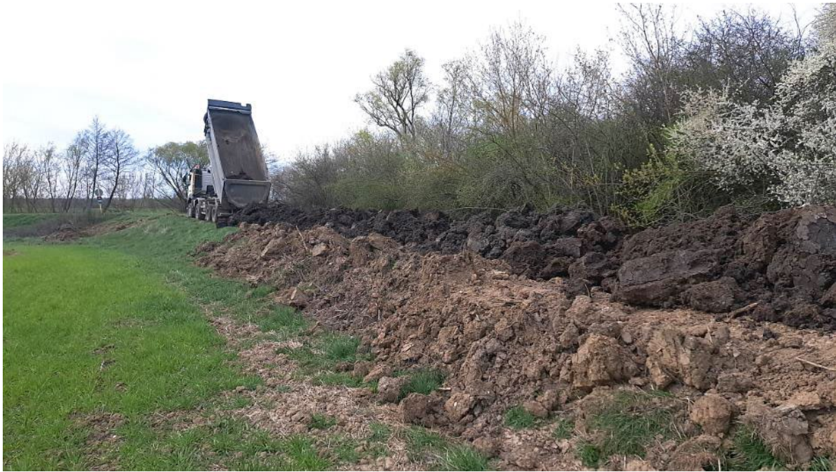
Obr. 24 - Navážanie zeminy k úprave hrádze
