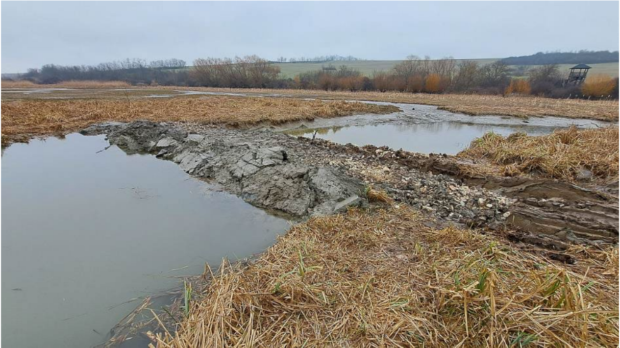
Obr. 1 - Prehradenie starého toku rieky Žitava – príprava staveniska
