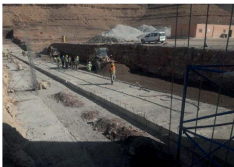
Ukládání válcovaného betonu v pravém svahu – šikmo
