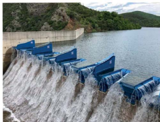
Schéma uzávěru typu "fusagate" a foto po dokončení realizace.
