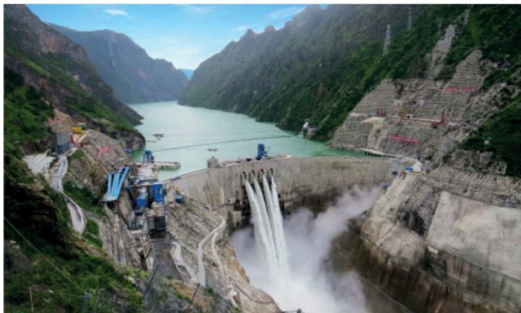
Klenbová přehrada Jinping I
