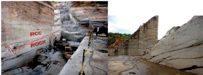
Přehrada Camará v průběhu rekonstrukce
