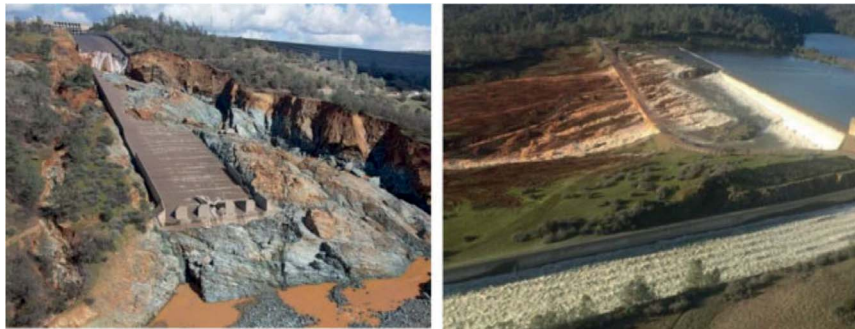
Porucha skluzu přehrady Oroville; zpětná eroze pod nouzovým přelivem
