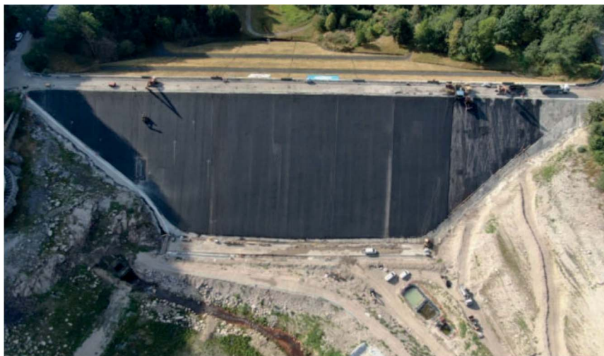
Nová asfaltobetonová vrstva návodního těsnění přehrady Kruth-Wildenstein
