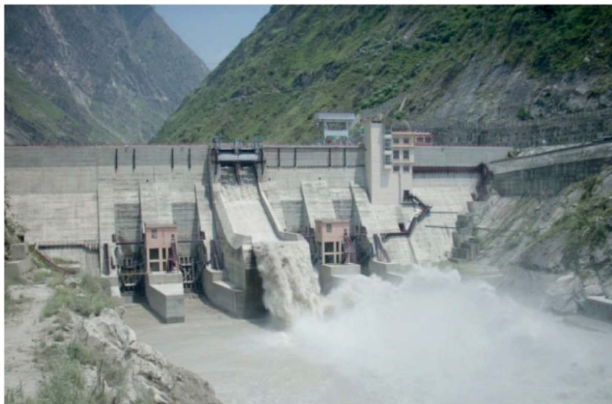
Spodní přelivy hrazené segmenty – z dolní vody
