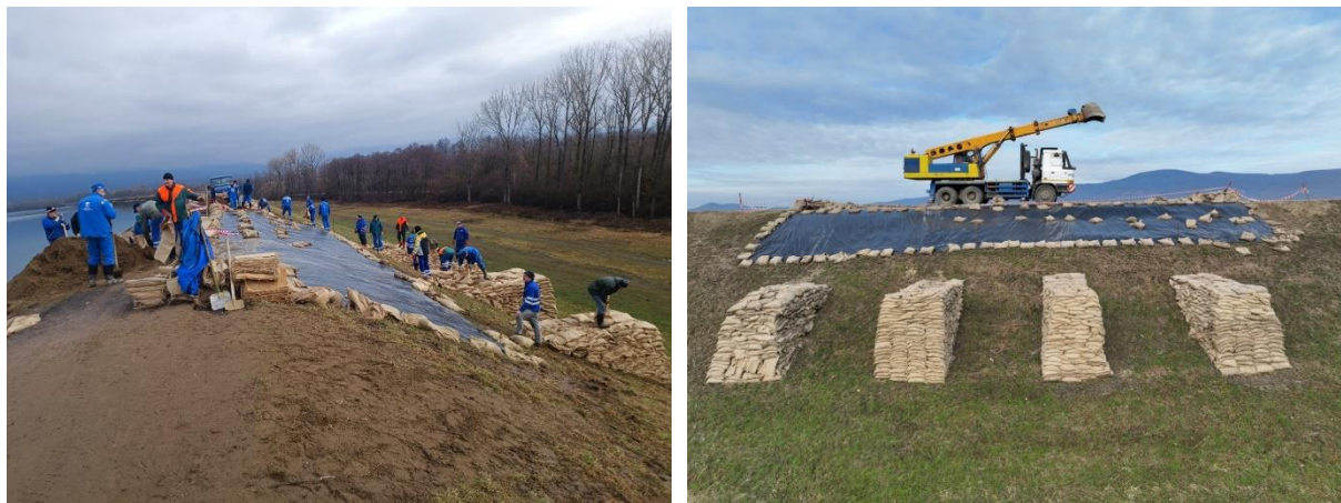
Obr. 2 Prifaženie svahu v mieste zosuvu vrecami s pieskom (rebrovaním) zo dňa 09.02.2024 a situácia v mieste zosuvu zo dňa 15.02.2024 (Foto: P. Pončák, S. Farkaš)
