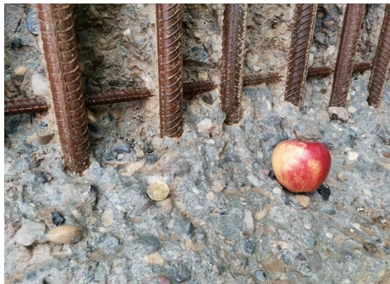
Obr. 4 Detail velikosti použitého kameniva a výztuže přelivu VD Nechranice
