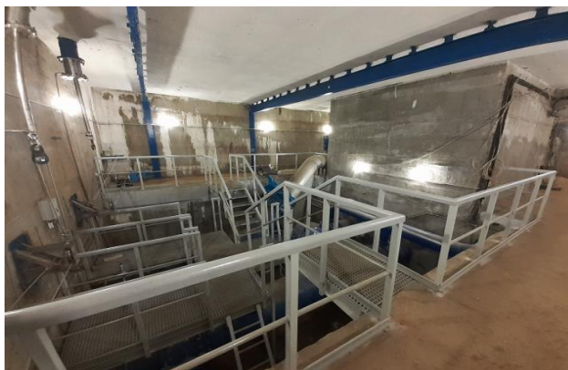
Obr. 4 Objekt strojovne po oprave
