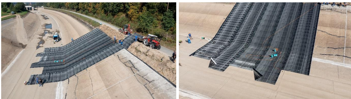
Obr. 5 Realizácia pokládky geomembrány v km 15,050 - 15,200
