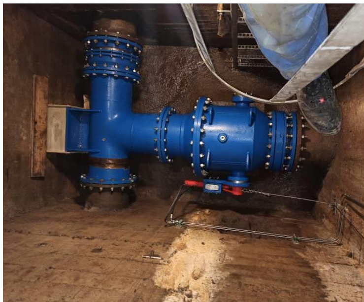
Obr. 5 Osazený uzávěr (Ševčík HYDRO s.r.o.)
