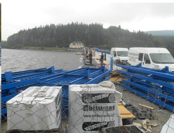
Obr. 3 Príprava montáže zábradlia
