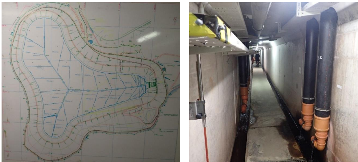
Obr. 3 VD Goldisthal, vľavo drenážní systém horní nádrže, vpravo pohľad do drenážní chodby
