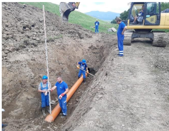
Obr. 5 Výmena zberného potrubia – rok 2021 (autor: Ing. Pončák)
