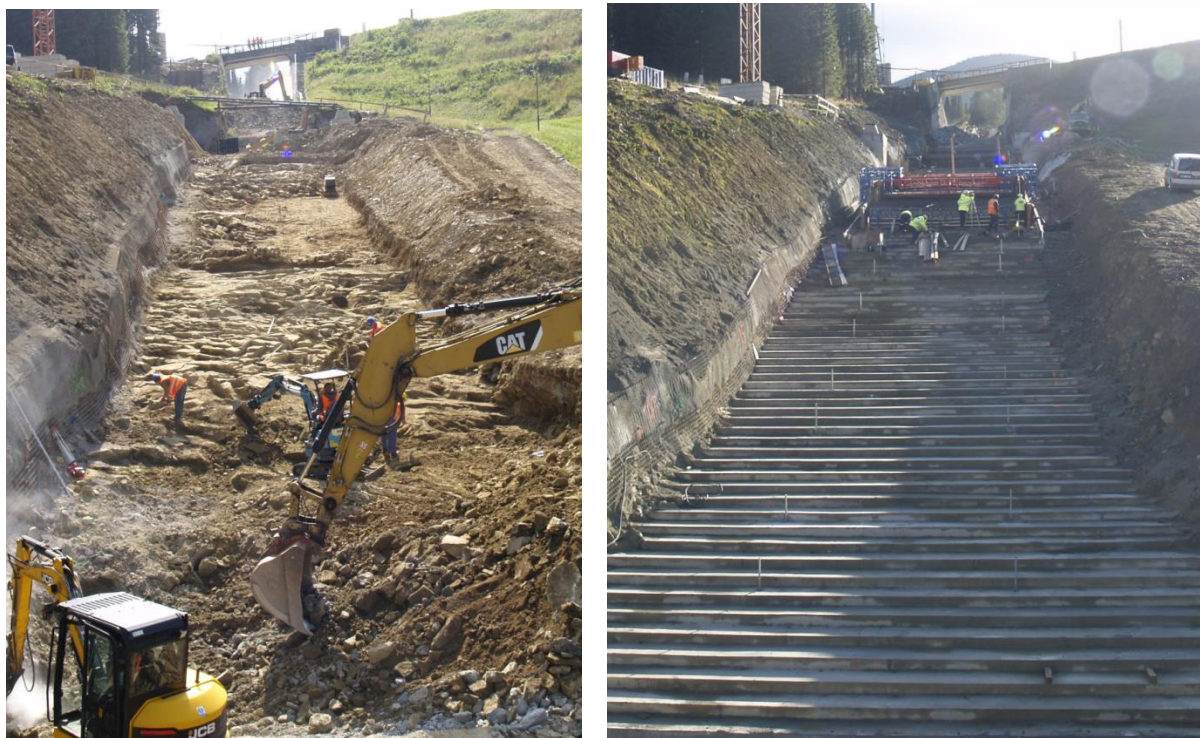
Obr. 2 Výlom a podkladní beton skluzu
