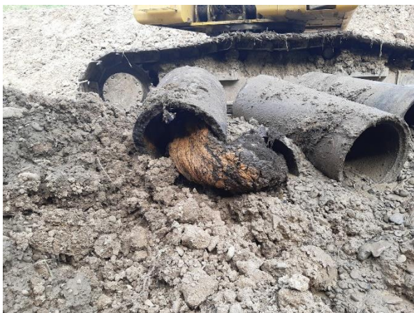
Obr. 5 Výmena zberného potrubia – rok 2021 (autor: Ing. Pončák)
