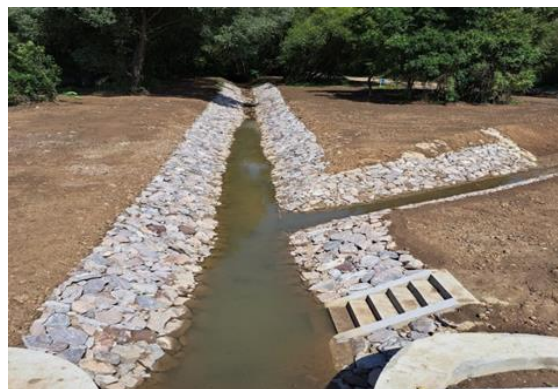
Obr. 8 Úprava Branovského potoka a Hastrgáňa
