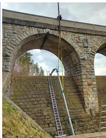
Obr. 2 Dočasná konstrukce násosky
