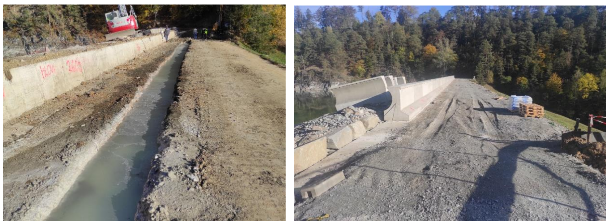
Obr. 2 Koruna hráze VD Letovice při rekonstrukci
