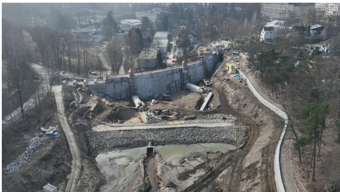
Obr. 1 Pohled na hráz v průběhu realizace akce
