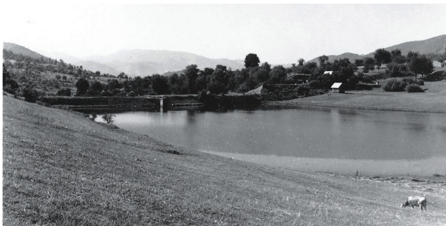
Obr. 1 Zachovaná fotografia vodnej nádrže Tajch z 2. polovice 20. storočia [1]
