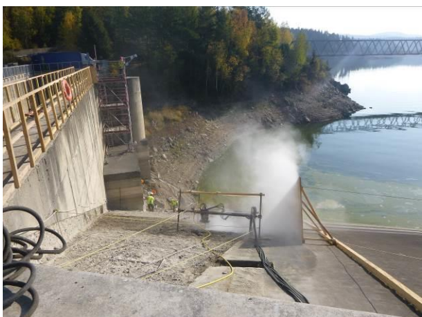
Obr. 7 Realizace na VD Stanovice, pohled z koruny hráze
