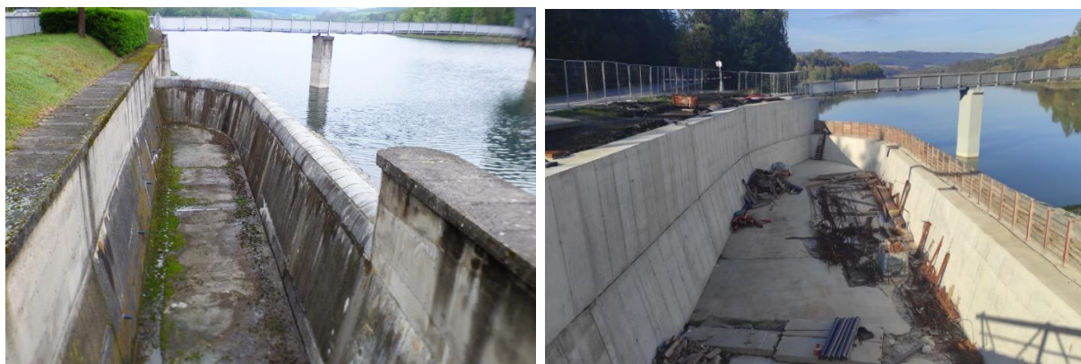
Obr. 4 Bezpečnostní přeliv a spadiště VD Letovice při rekonstrukci
