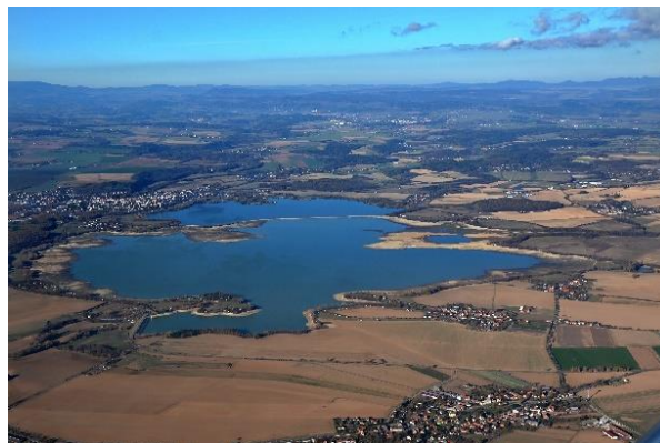
Obr. 6 Letecký pohled na VD Rozkoš
