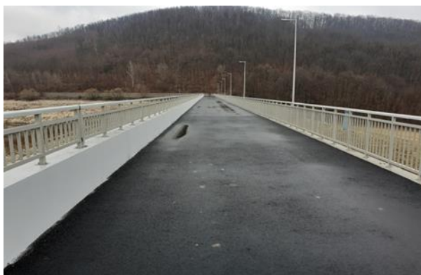
Obr. 1 Komunikácia na ochrannej hrádzi po oprave
