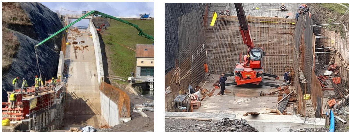
Obr. 6 Vývar VD Letovice při rekonstrukci
