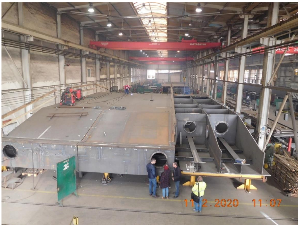
Obr. 2 Výroba Oceľových konštrukcií vo výrobní MTS v Prahe - Horné Počernice
