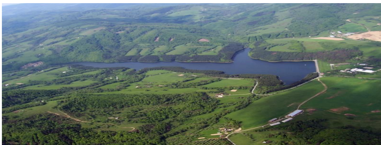
Obr. 1 Vodárenská nádrž Klenovec
