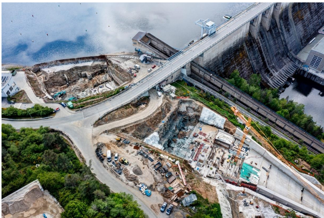
Obr. 4 Rozpracovanost na objektech SO 01 – vtoková část a SO 03 – otevřená část skluzu
