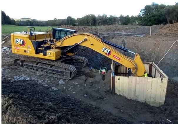
Obr. 3 Příprava šachtice pro provedení geotechnických zkoušek.
