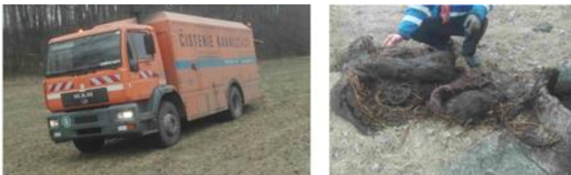
Obr. 3 Čistenie pôvodného betónového potrubia (autor: Ing. Pončák)
