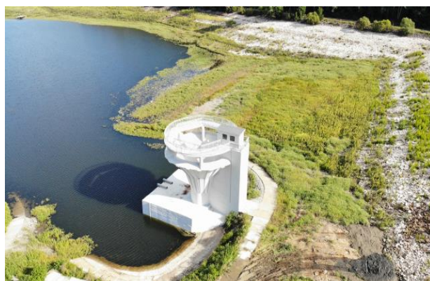
Obr. 2 Združený funkčný objekt po oprave
