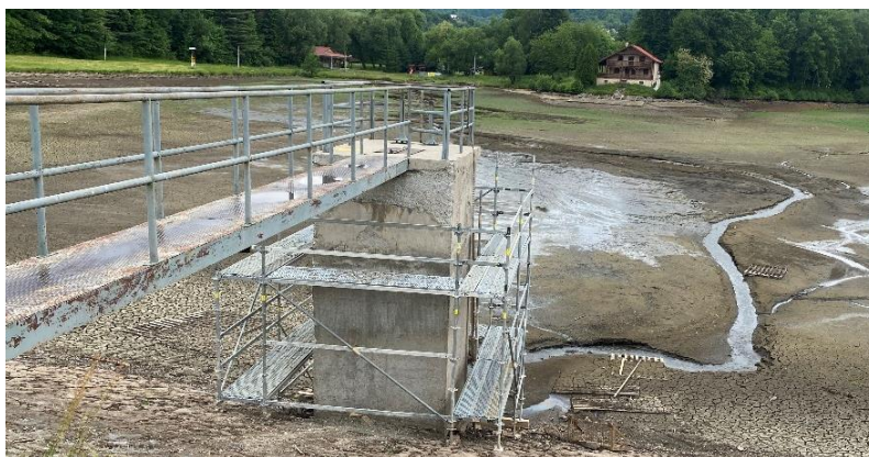
Obr. 4 Pohľad na vypustenú nádrž a výpustný objekt
