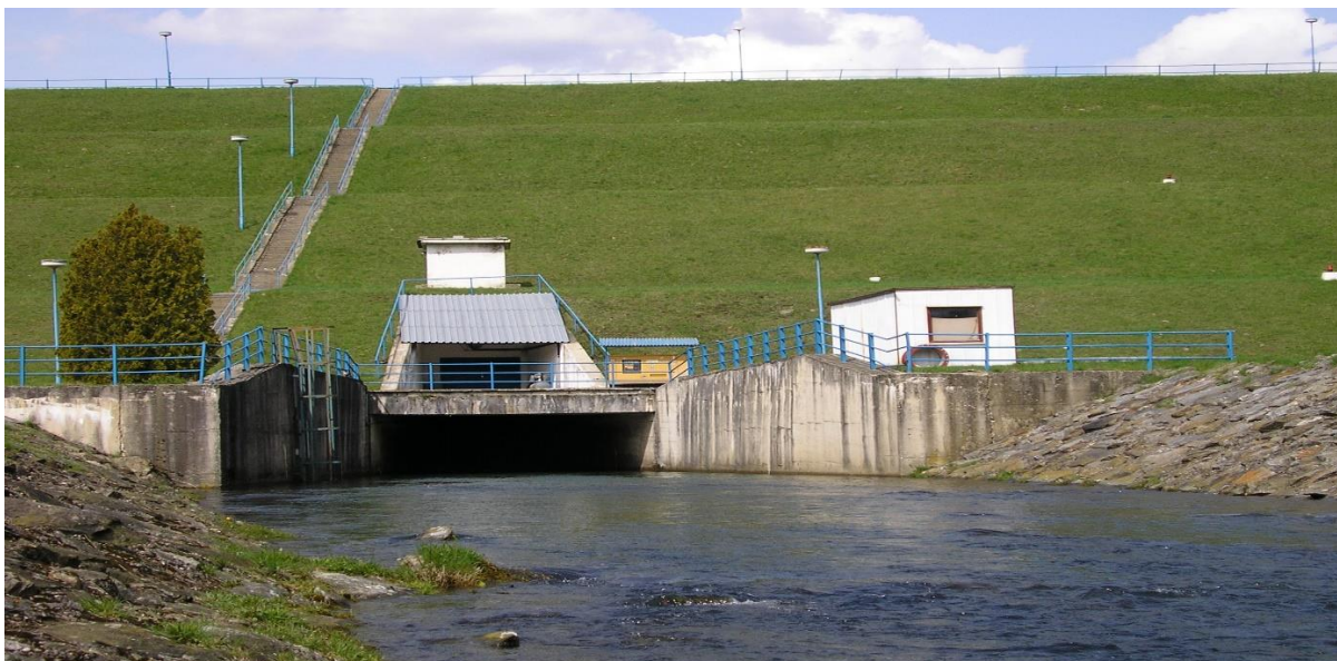
Obr. 3 Pohľad na odpadovú a komunikačnú štôľňu
