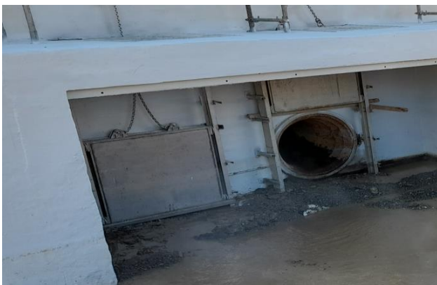
Obr. 5 Nové tabule provizórneho hradenia
