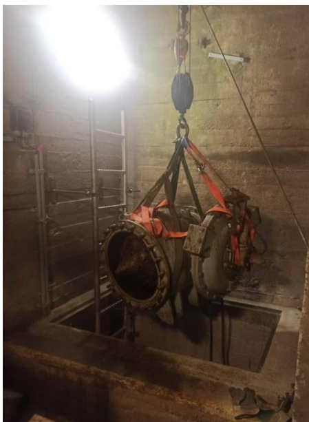
Obr. 4 Přesun původního uzávěru
