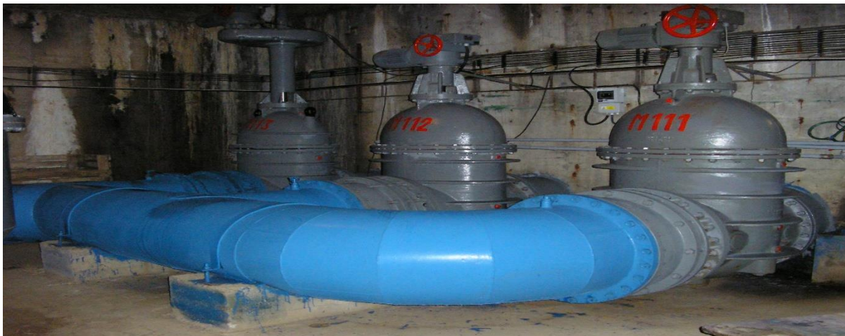
Obr. 2 Vyústenie vodárenských odberov do strojovne
