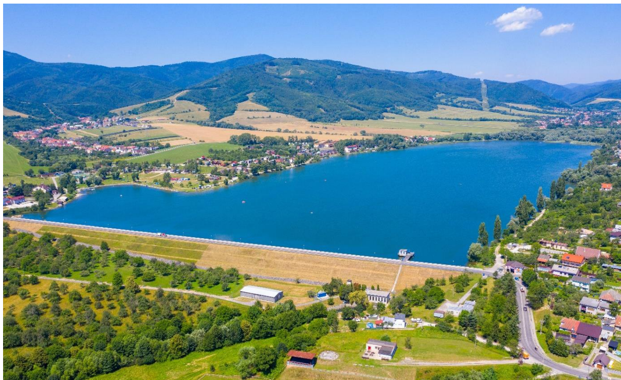
Obr. 2 Pohľad na VN Nitrianske Rudno
