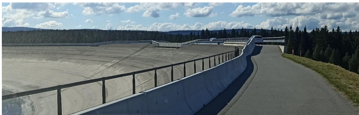
Obr. 5 VD Markersbach, navýšení a úpravy na koruně hráze
