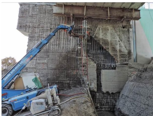
Obr. 1 Dodatečně upravený manipulátor pro obsluhu bouracího robota
