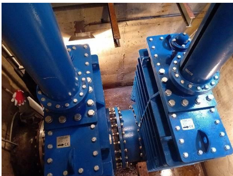
Obr. 1 Desková šoupata na VD Sedlice
