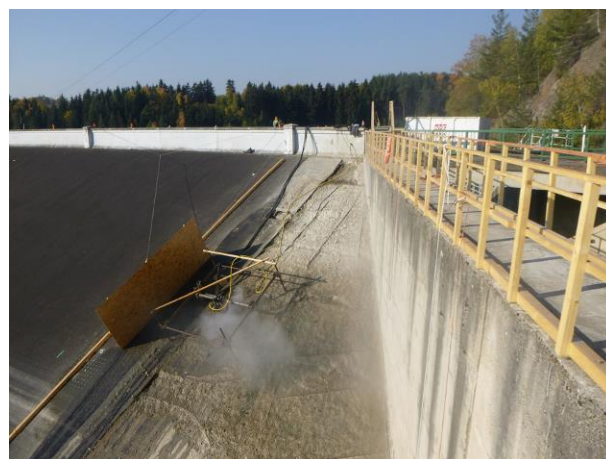
Obr. 8 Realizace na VD Stanovice, pohled z bezpečnostního přelivu
