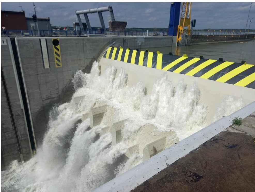
Obr. 4 Horné vráta počas komplexných skúšok (haťová prevádzka)
