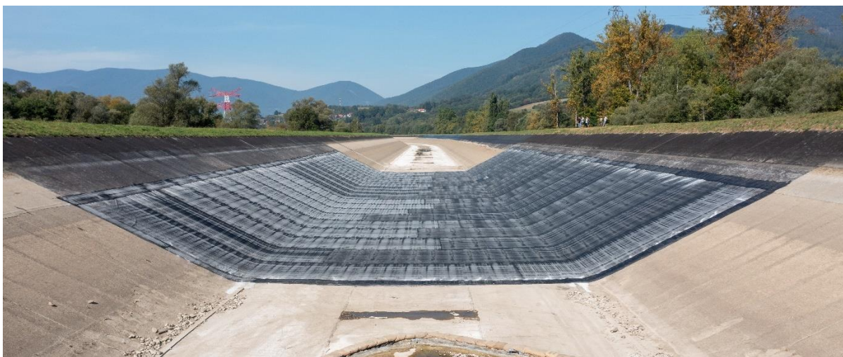
Obr. 6 Dokončená pokládka geomembrány v celom profile kanála v km 10,070 - 10,170
