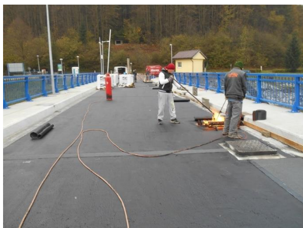
Obr. 2 Izolácia na korune hrázde
