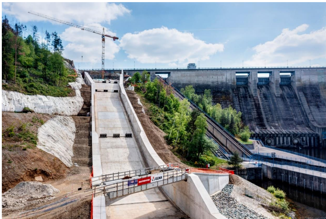
Obr. 5 Realizace stavebního objektu SO 03 – otevřená část skluzu (květen 2024)
