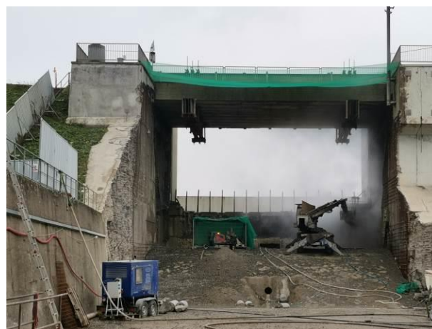
Obr. 2 Pohled na pracoviště při probíhající hydrodemolici
