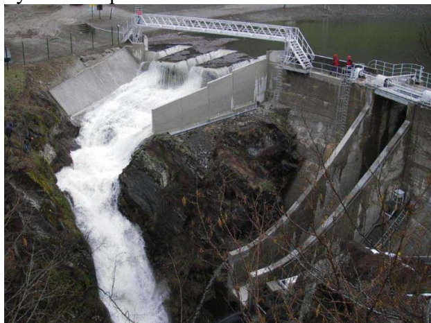
Obr. 1 Doplnkový bezpečnostní pianový přeliv na přehradě Goulours ve Francii [1]
