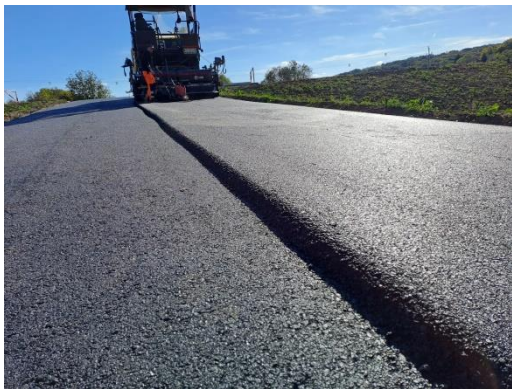
Obr. 9 Kladenie asfaltu na účelovú vozovku
