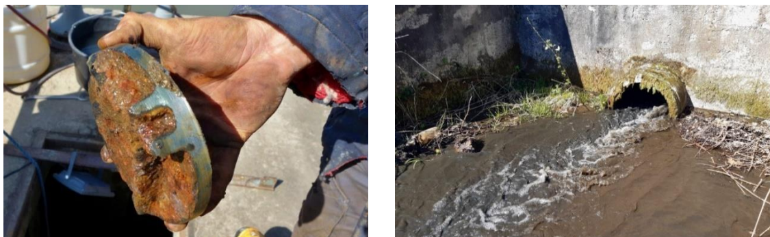
Obr. 3 Odvrátný uzáver a následné pretekanie vody cez dnový výpust [4]
