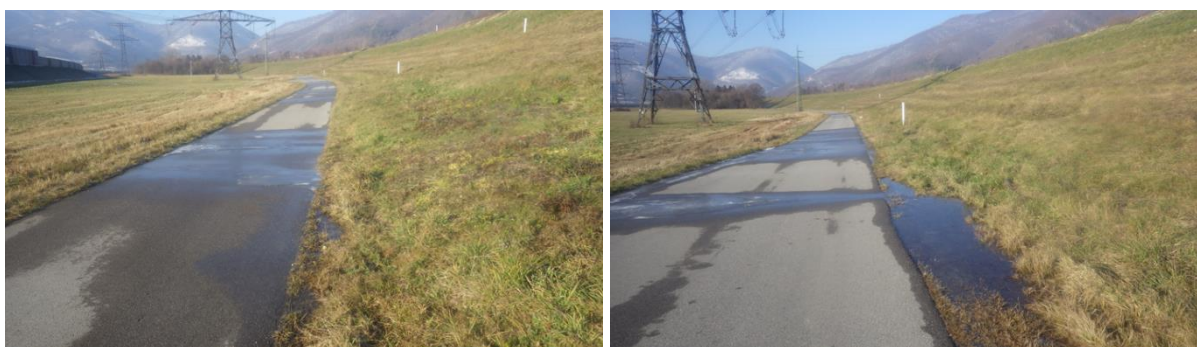
Obr. 3 Podmáčaná päť ľavostrannej hrádze PK Lipovec v km 13,300 - 13,500
