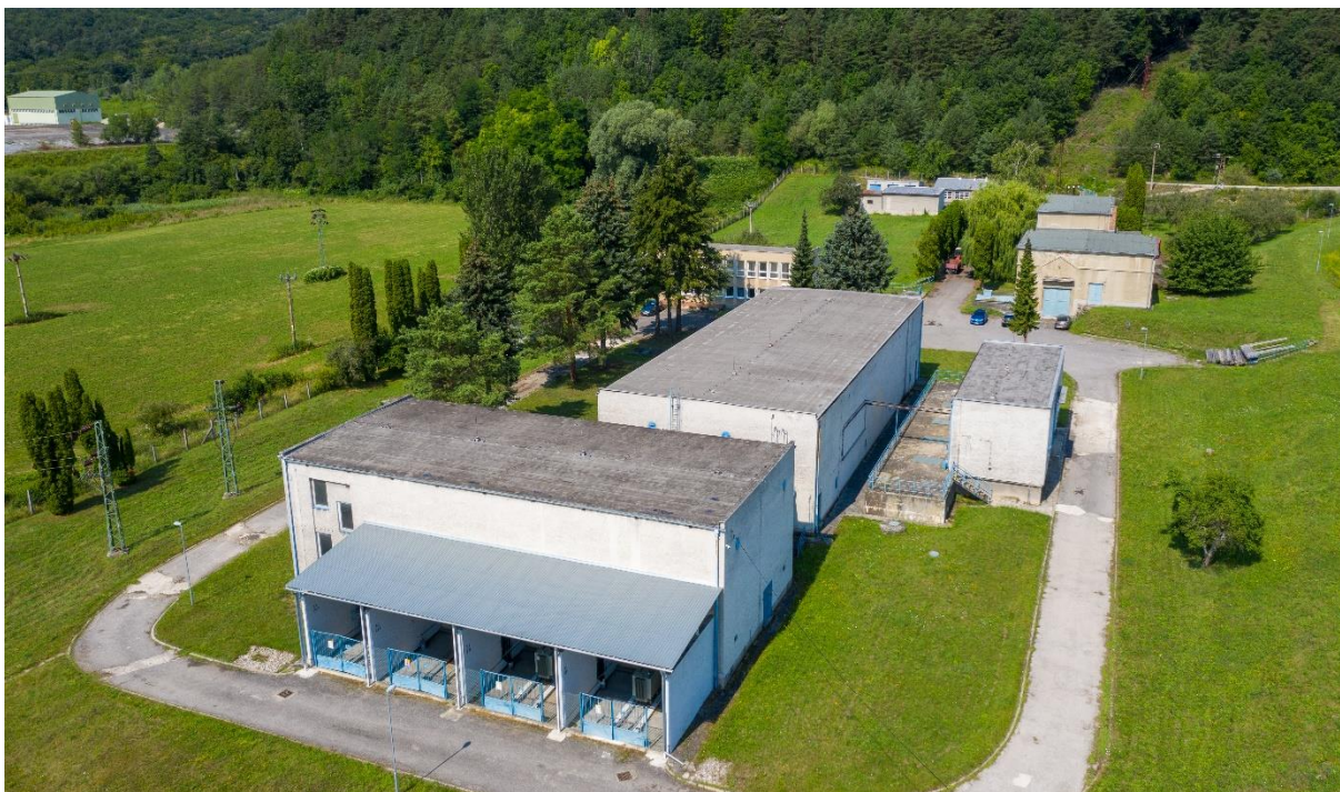
Obr. 3 Pohľad na Čerpaciu stanicu Nováky
