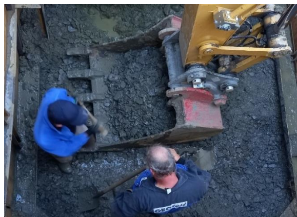
Obr. 3 Příprava šachtice pro provedení geotechnických zkoušek.
