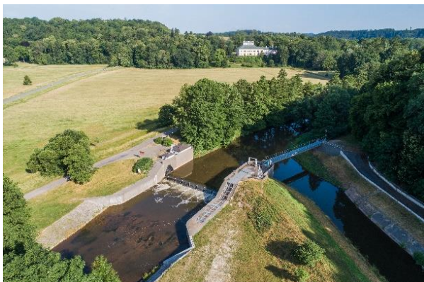
Obr. 5 VD Zlič - Rozdělovací objekt na Úpě
