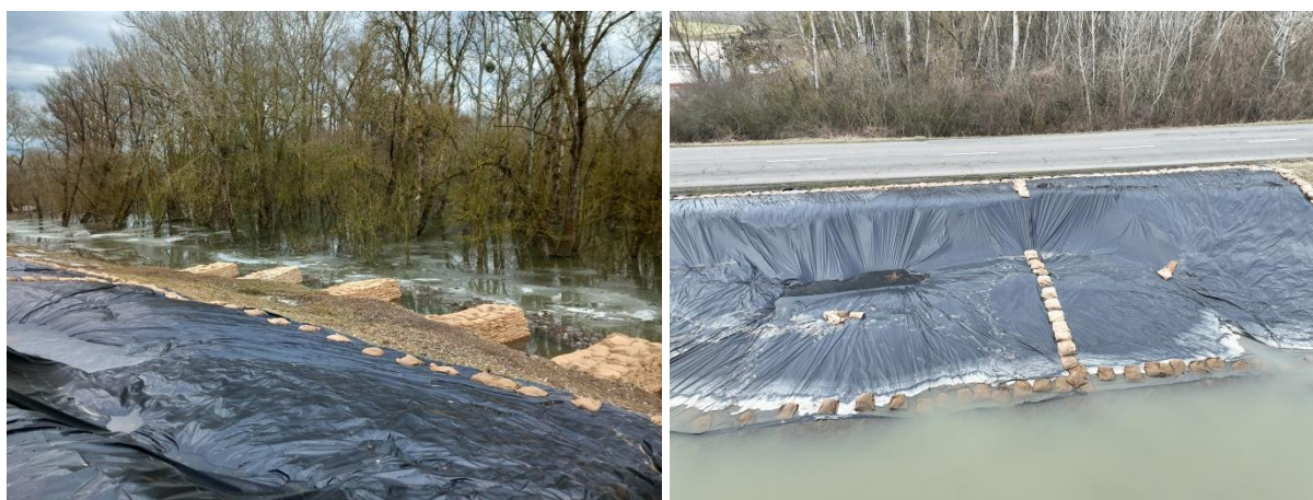
Obr. 1 Pohľad na miesto zosuvu návodného svahu pravobrežnej hrádzce Laborca zo dňa 01.02.2024 a 15.02.2024 (Foto: A. Šoltisová, S. Farkaš)
