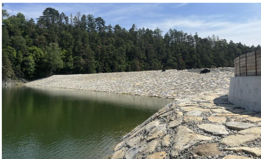
Obr. 3 Opevnění návodního líce VD Letovice při rekonstrukci
