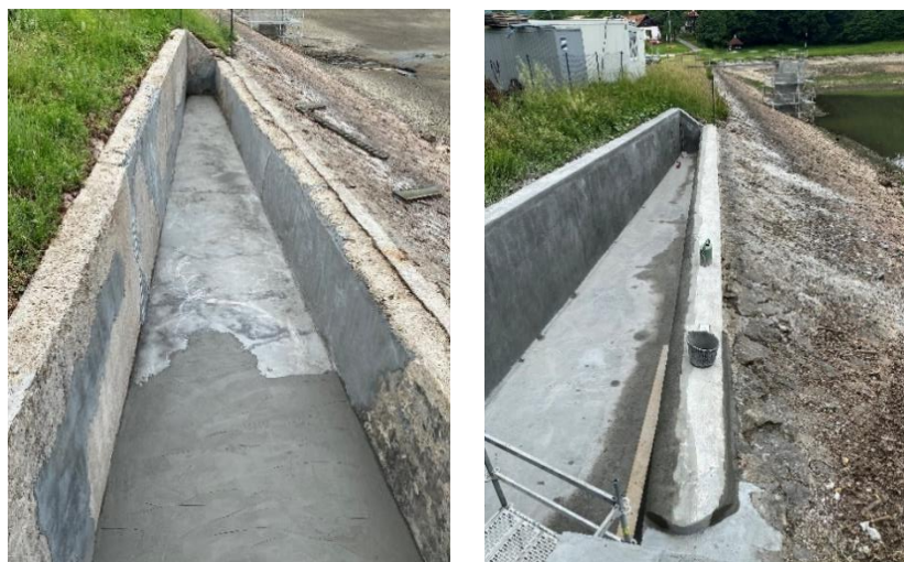
Obr. 5 Pohľad na hranu bezpečnostného priepadu po otryskávaní so začatím sanácie maltou
